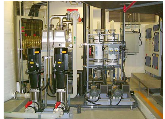
CO2 와 O2 제거를 위한Liqui-Cel Polishing System의 두번째 단계
